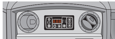
Comando de acionamento do ar condicionado e difusores de ar
