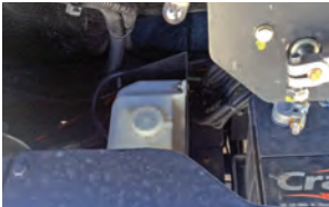
Detalhe do reservatório de água
